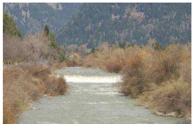
La briglia che confina il sito ad Ovest (c/o il ponte della Roda)
