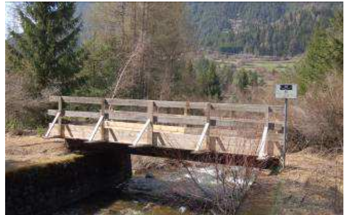
Ponticello "Marcialonga" sul Rio Sadole
