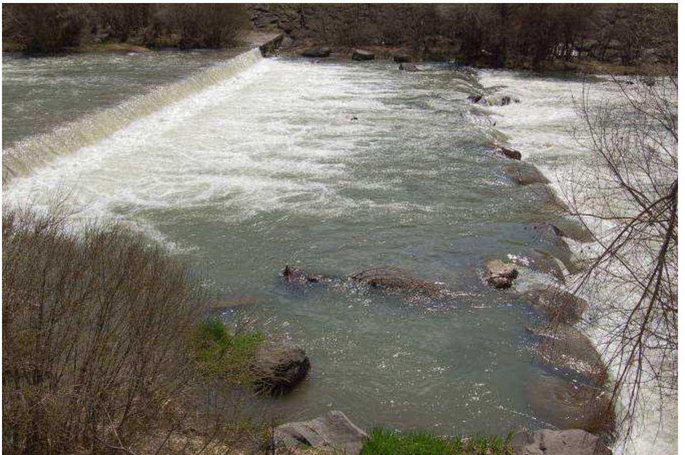
Briglie diverse in corrispondenza della porzione centrale
