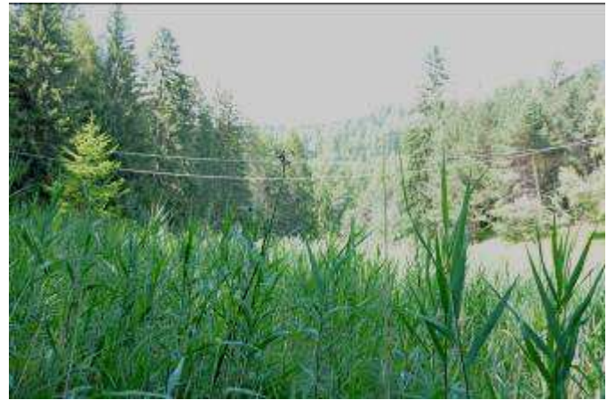
Particolare: l'attraversamento della linea elettrica
